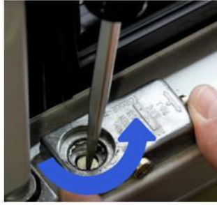
拆除扭簧底座 Remove TorqueMaster
