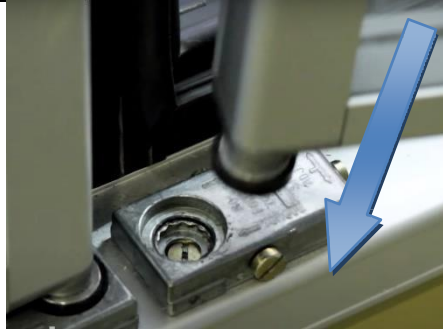
插入扭杆 Insert Torque Rod
